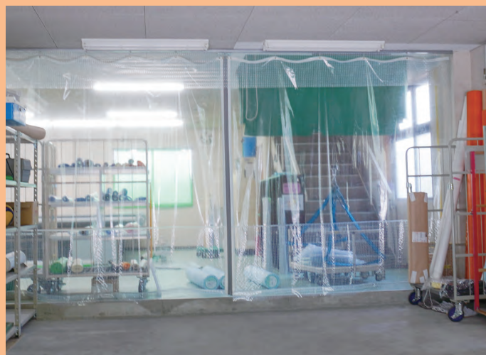
●倉庫内間仕切
