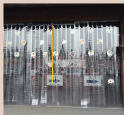
外部出入口に
