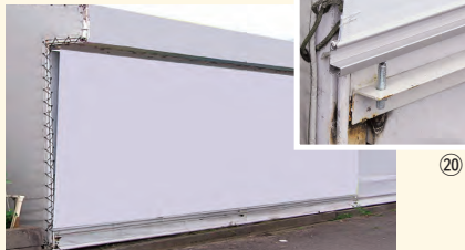
■倉庫壁面にサインシート 19
